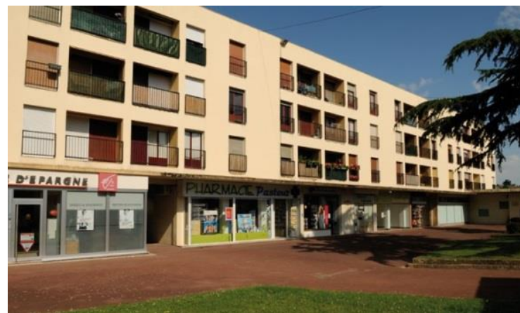
Vue intérieure du centre commercial Pasteur
